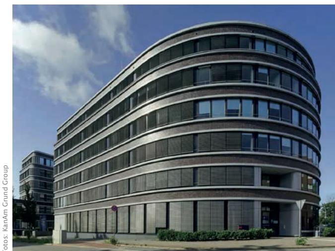
Hammerstraße 30-34, Hamburg DGNB-Platin zertifiziertes, taxonomiekonformes Gebäude
